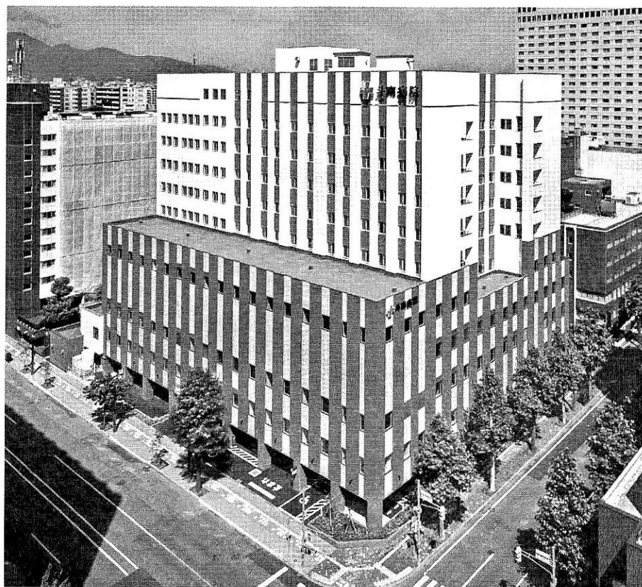
斗南病院 全景
